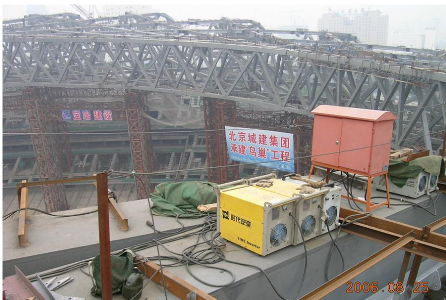
奥运场馆工程
